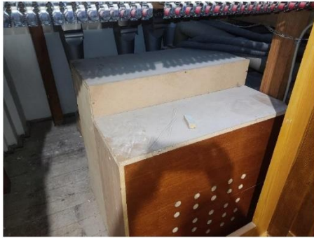
ZATEČENO STANJE I ČIŠĆENJE
